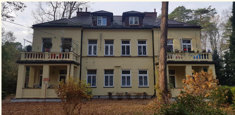
Rysunek 15. Termomodernizacja budynku przy ul. Jaworowej 72
