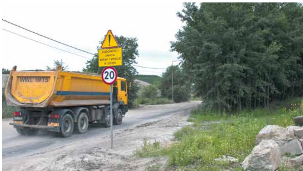
* Drogi prowadzące do autostrady zostaną naprawione
