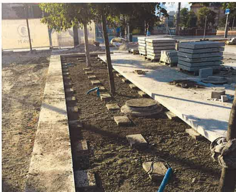
Ryc. 9 Konstrukcja podwieszonoego chodnika nad korzeniami drzew (fot. Ziemiańska)
