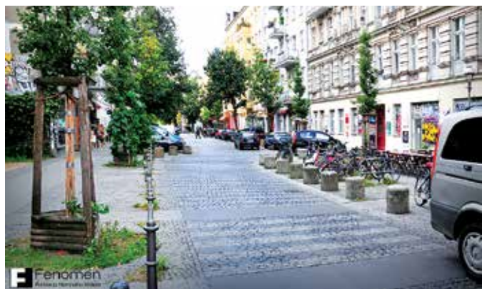
Fot. 6 Woonerf w Berlinie https://www.fundacijafenomen.pl/ czyli europejski sposób kształtowania pasa drogowego podporządkowanego pieszym i środowisku
