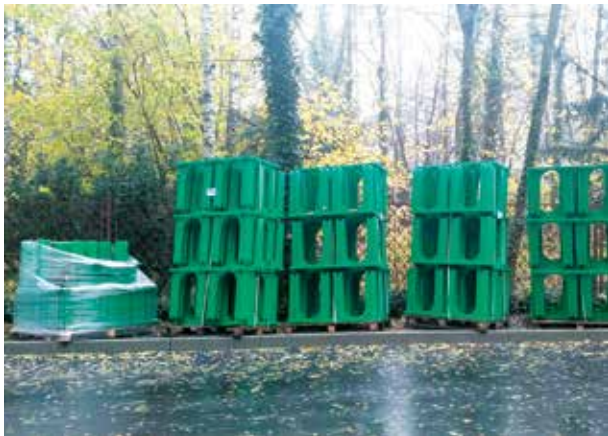
Fot. 14 i 15. Budowa drenażu zbierającego nadmiar wód opadowych i skrzynki retencyjne przed montażem.
