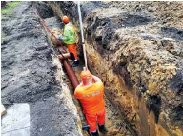
Fot. 14 i 15. Budowa drenażu zbierającego nadmiar wód opadowych i skrzynki retencyjne przed montażem.
