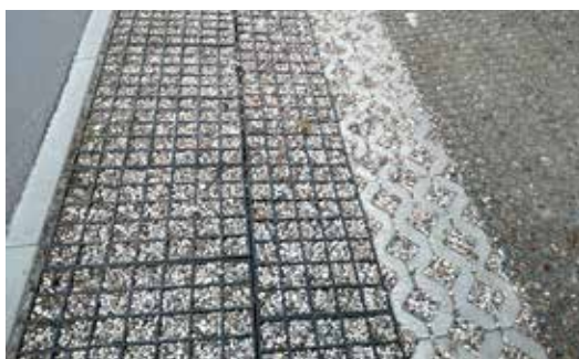
Fot. 17. Fragment wzmocnienia pobocza chłonnego „ekokratą” PVC i betonową ma uchronić pobocze przed zniszczeniem przez parkujące samochody.
